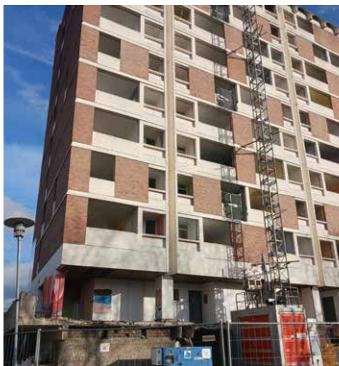
Travaux de préparation de la démolition de la Tour Charon-quartier de la Croix-Blanche
