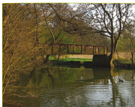
Passerelle métallique de Périgny sur Yerres
