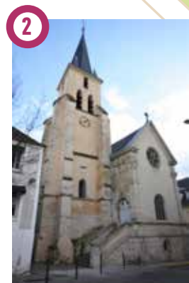
Eglise Saint-Médard, 14 rue Monmartel, Brunoy Située à l'emplacement d'une chapelle mérovingienne, l'église actuelle est classée au titre des Monuments historiques. La partie la plus ancienne est située au sud de la nef date du XII e siècle tandis que le chœur, voûté sur croisées d'ogives asymétriques, est du XIII e siècle, la tour des cloches et la partie nord du XVI e .
