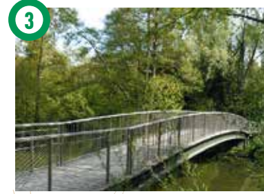
3 Bords de l'Yverres, Boussey-Saint-Antoine Parc, sentier, passerelle et vieux pont se trouveront sur votre chemin.
