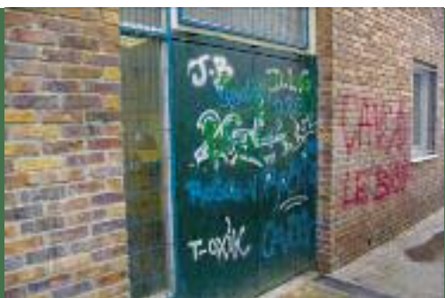
Avant les travaux
