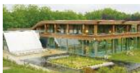
Piscine des Sénarts Piscine Loisirs Fosse de plongée de 12m de profondeur
