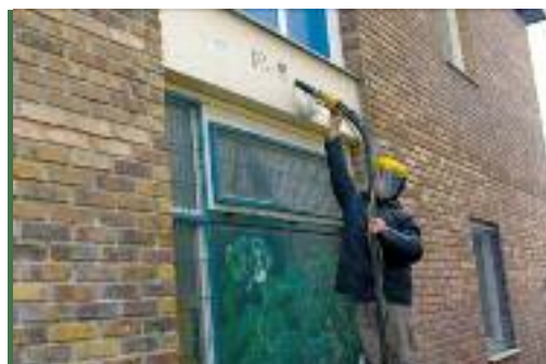
Pendant les travaux
