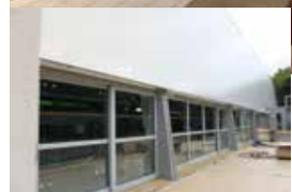
Les travaux ont porté essentiellement sur l'isolation du bâtiment avec le remplacement de la totalité de la façade translucide par des panneaux en polycarbonate. A noter également
